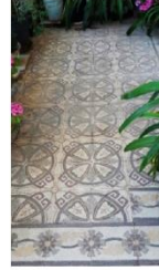
Avlu mekanında yer döşemesi örneği (url 3)
